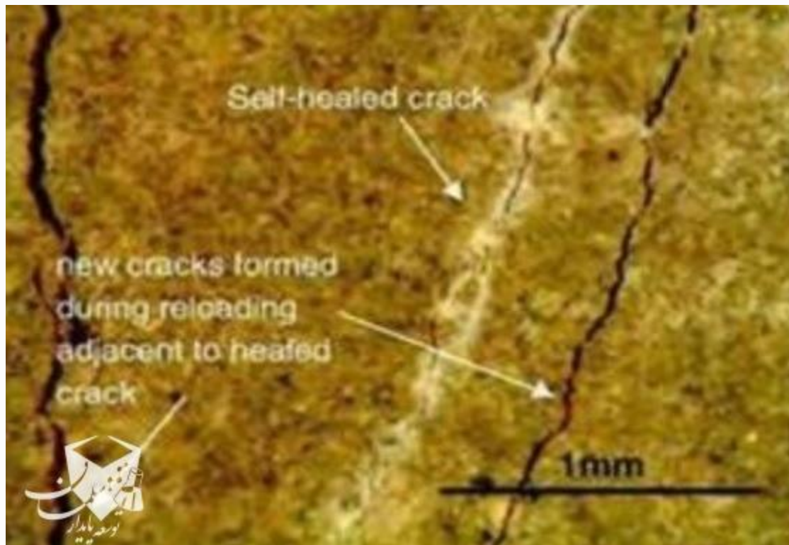
خودترمیمی ترک در بتن ECC و گسترش ترک پس از بارگذاری مجدد نمونه در محلی غیر از موقعیت ترمیم شده
